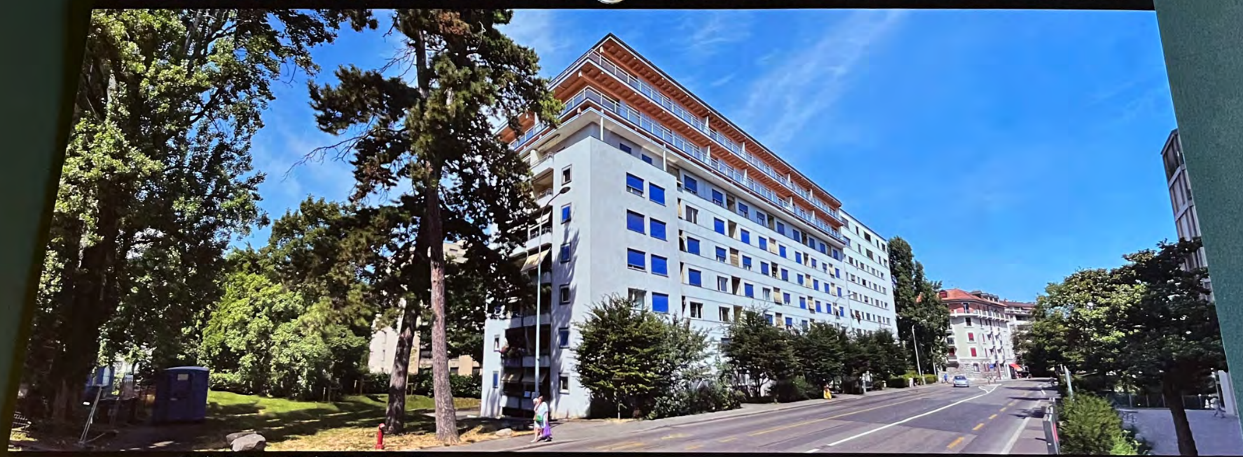
Surélévation Avenue Wendt 29-33, Genève (GE)
