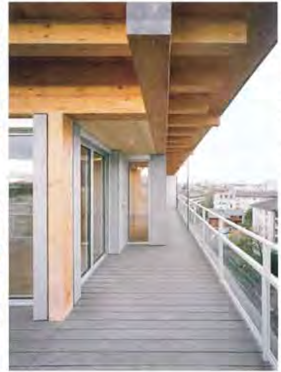
Am Bestand in derselben Strasse lassen sich historische Anleihen erkennen. In der Konstruktion der Dachwohnungen bleibt das Holz als Material sichtbar.
