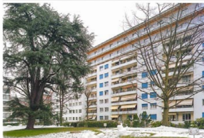
Surélévation par une structure légère en bois d'un immeuble des années cinquante à l'avenue Wendt à Genève, arch. Lacroix Chessex (O. DI GIAMBATTISTA)
