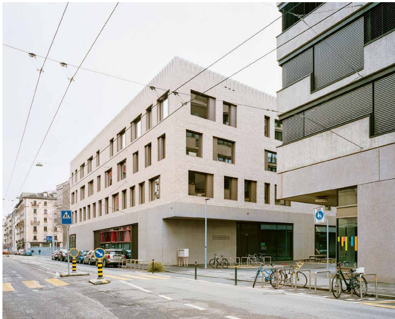
En bordure du boulevard Saint George, ce nouvel équipement est l'ultime pièce de l'écoquartier de la Jonction.
