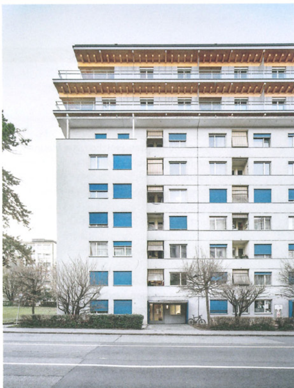
Die hölzerne Aufstockung hebt sich vom Bestand ab. Sein Vordach bildete den entwerferischen Anknüpfungspunkt für die Erweiterung.
