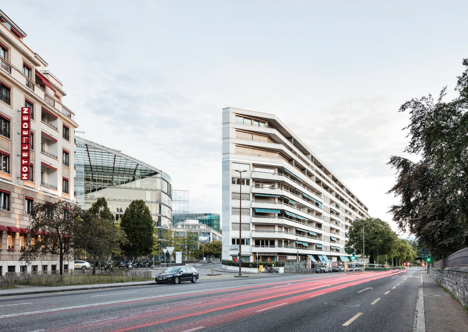
Surélévation de 3 étages aux allées 137 à 147 de la rue de Lausanne, à l'entrée de Genève. Ce projet a abouti à la création de 50 logements. | Image: Olivier di Giambattista
