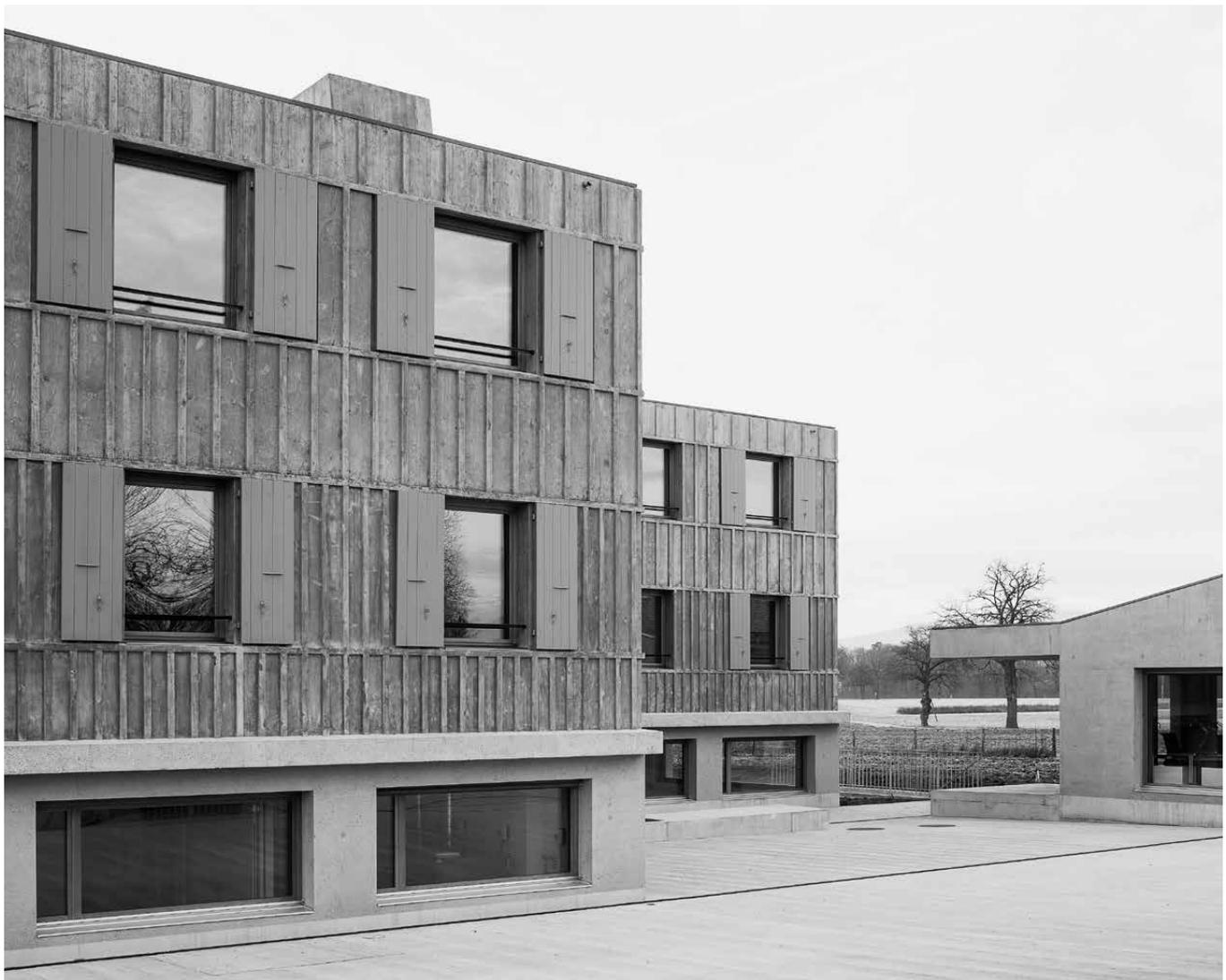
de ce jeu optique-haptique est tel que l'observateur à distance peine à imaginer que ces bâtiments sont entièrement construits en béton.
